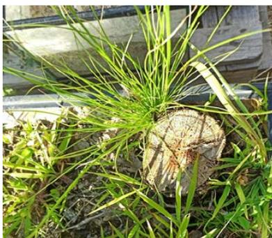
**Figure 4 : Dégradation du bois induite par une infestation par les racines d'une couverture végétale.**
