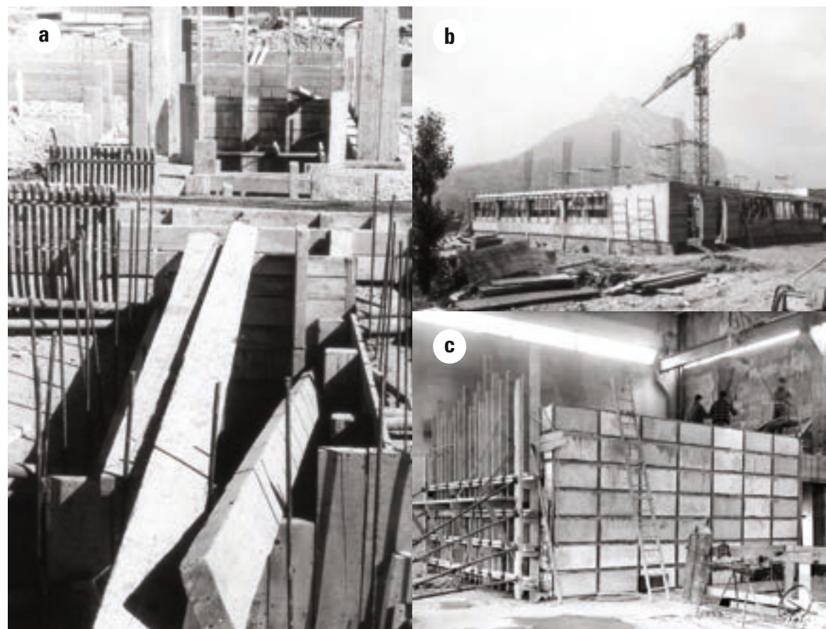
Construction de l'irradiateur en 1965. Dans l'ordre chronologique : bloc piscine (a), bâtiment R (b) et cellule d'irradiation (c).
