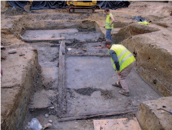
Les poutres sablières lors de leur découverte.
