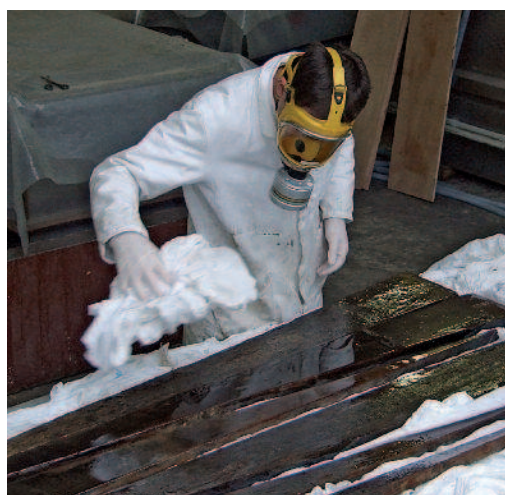
Le traitement des éléments de planchers : sortie de la cuve d'imprégnation (ci-dessus) et nettoyage avant polymérisation (à droite).
