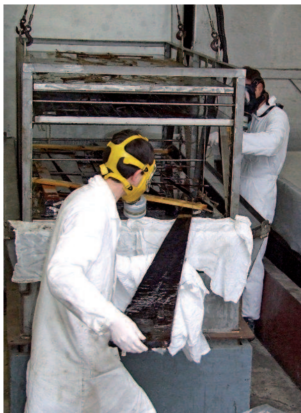
Le traitement des éléments de planchers : sortie de la cuve d'imprégnation (ci-dessus) et nettoyage avant polymérisation (à droite).
