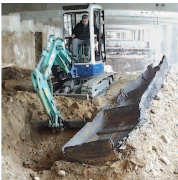
Dégagement à la pelleuse des abords de l'une des embarcations retrouvées sur le chantier du Parc Saint-Georges
