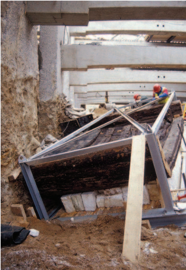
Section de l'épave n° 7 calée sur son support et prête au levage
