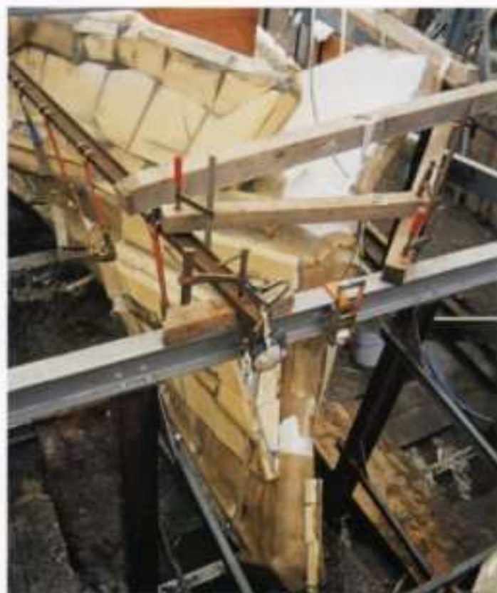
Application de mousse polyuréthane sur l'étrave
