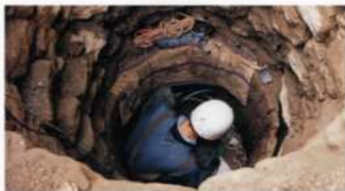
Cuvelage de puits (Grenoble)
