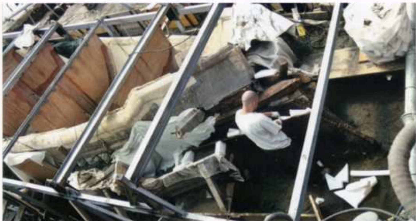
Préparation de l'étrave de l'épave C.
