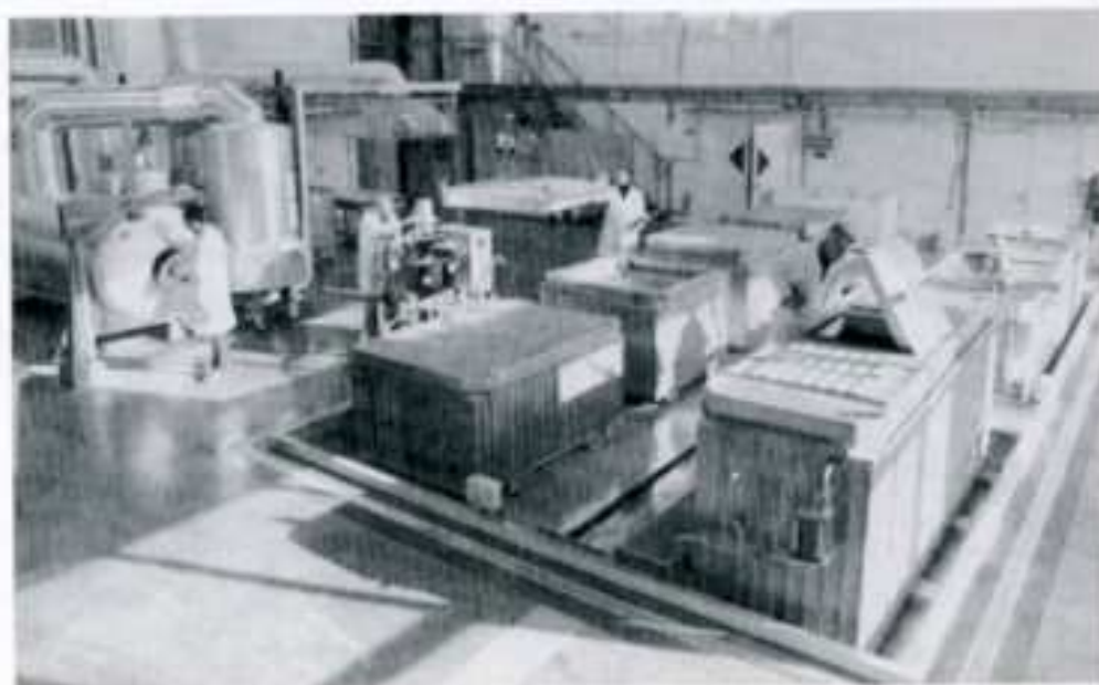
Installation d'imprégnation de PEG et lyophilisateur
